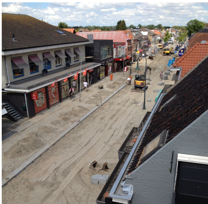
Voorstraat tijdens werkzaamheden fase 4.
